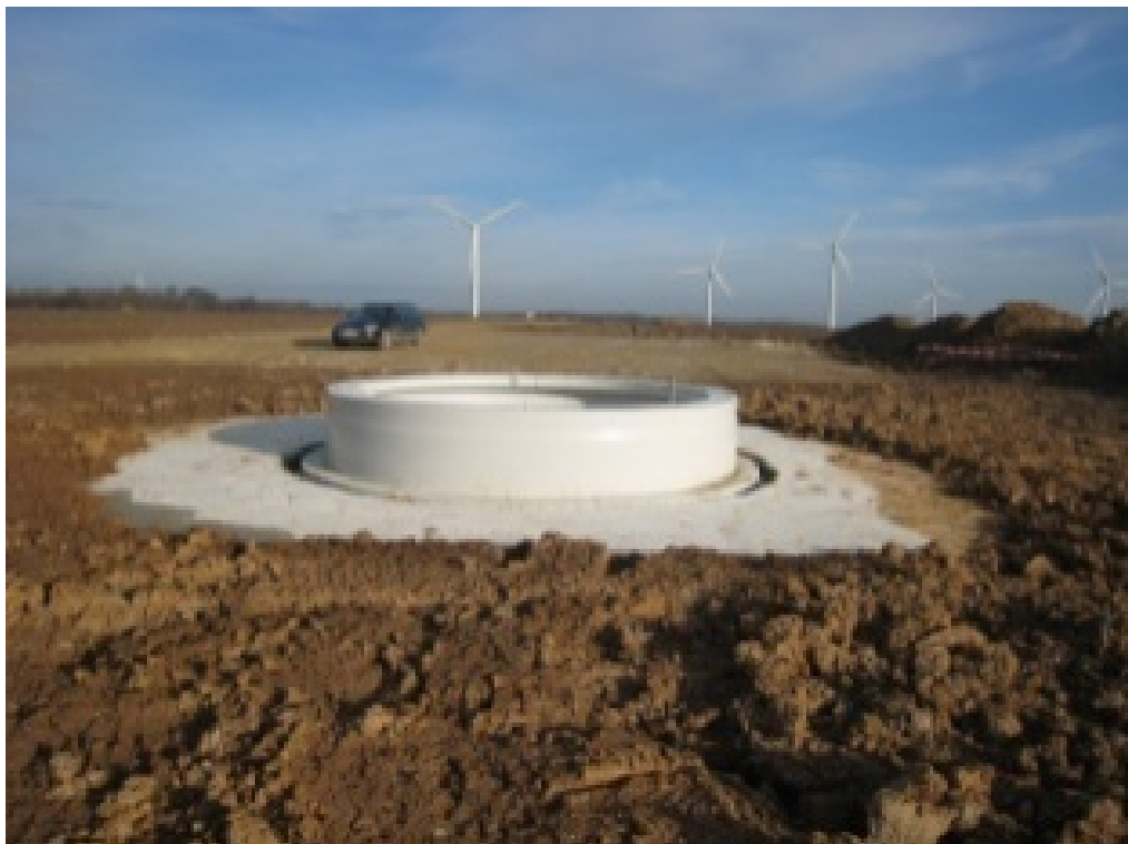
Imágenes 09. Base finalizada.
