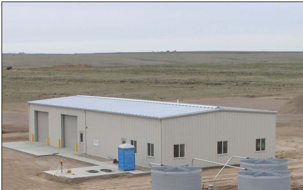
Imagen 11. Edificio del personal de mantenimiento
