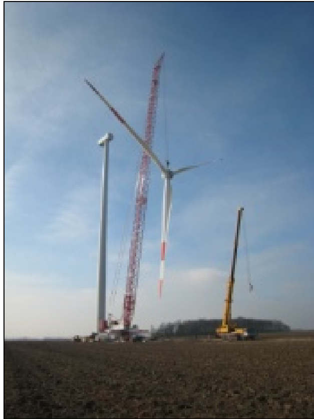
Imagen 18. Montaje de las palas.
