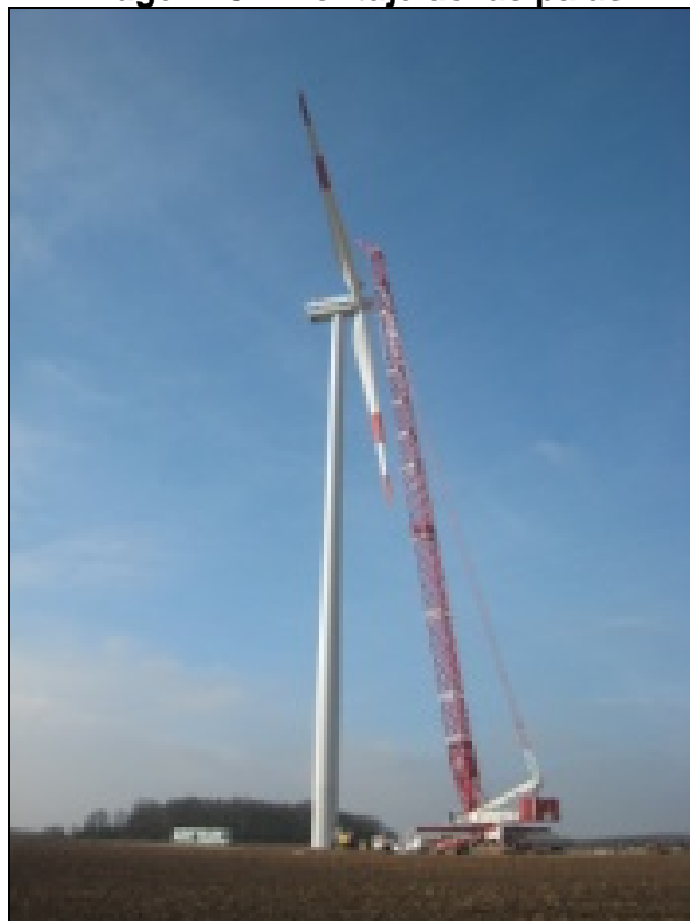
Imagen 19. Montaje de las palas.
