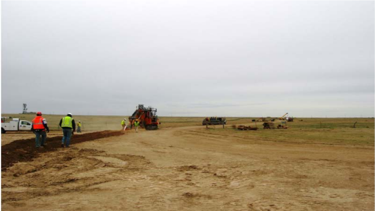
Imagen 20. Obra de tendido de cables subterráneos.
