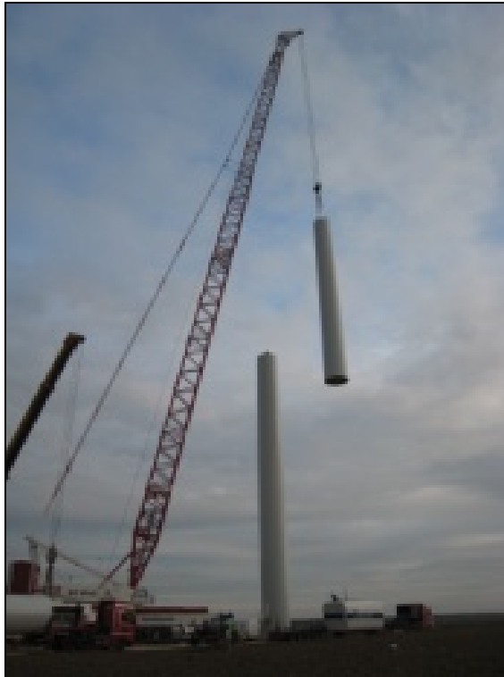
Imagen 16. Montaje de los segmentos de la torre de un aerogenerador.
