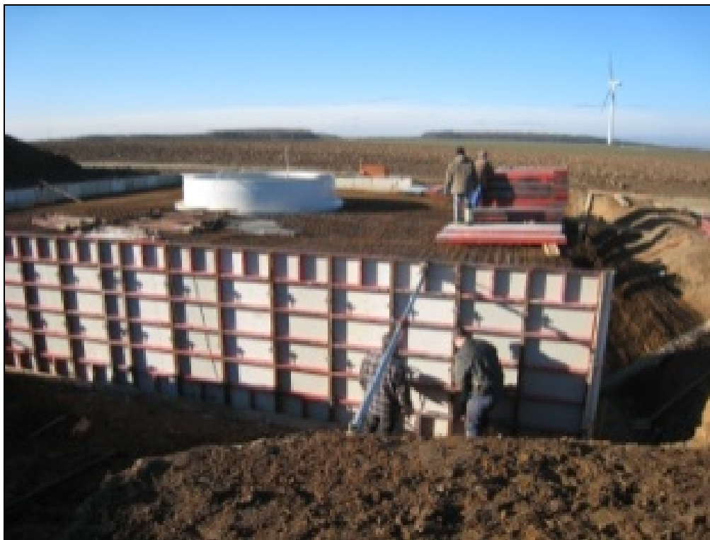
Imagen 06. Tareas de encofrado.
