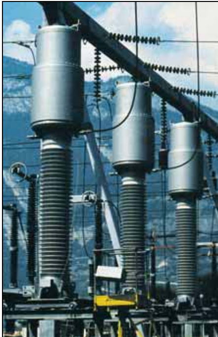
Imagen 29. Instrumento de Transformación
