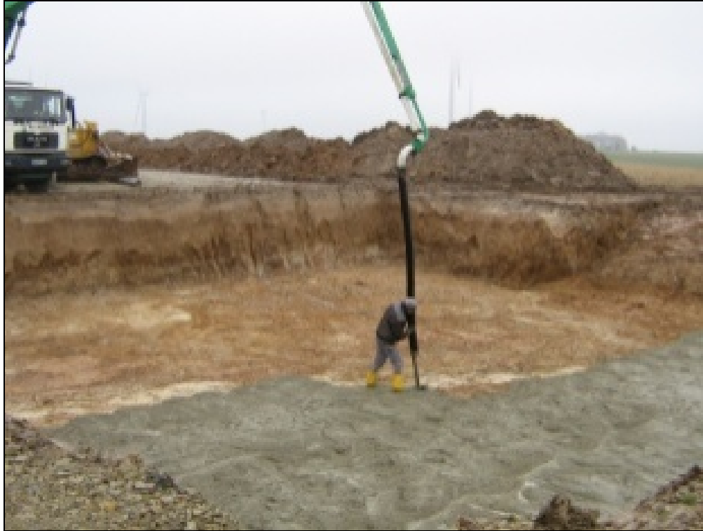
Imagen 05. Colocación de la capa de cierre.
