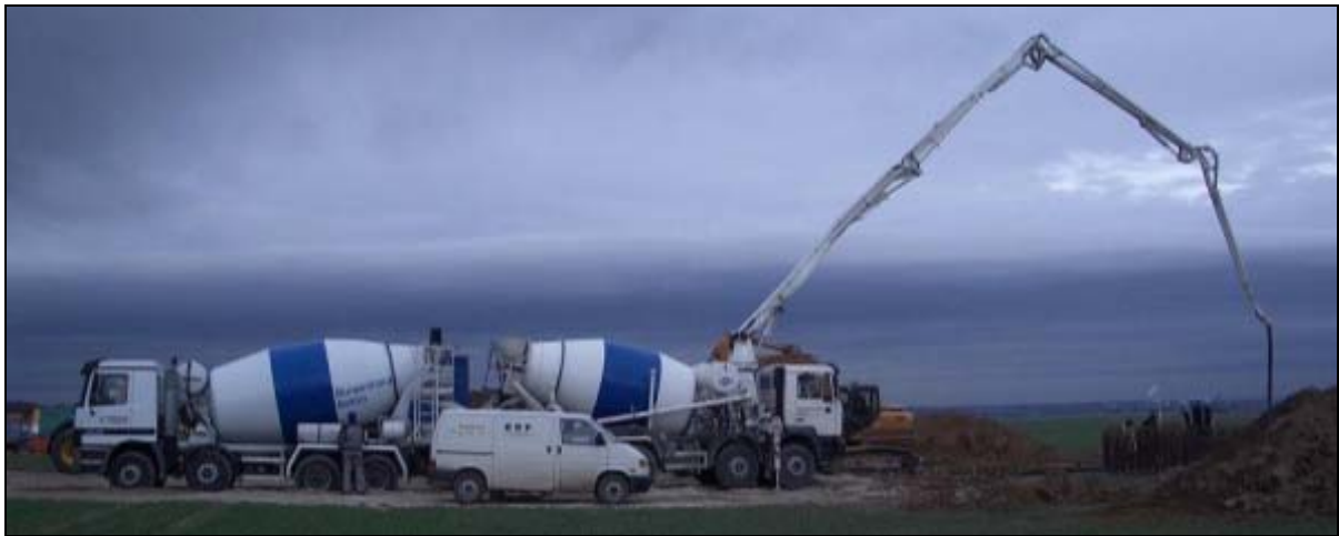
Imagen 07. Autobomba de hormigón rellenando la fundación
