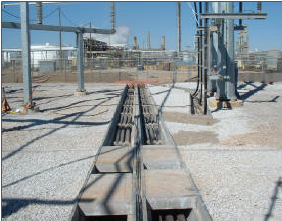
Imagen 22. Instalación de cableado subterráneo.
