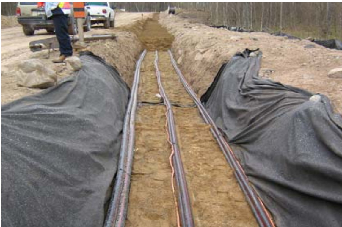
Imagen 21. Obra de tendido de 3 fases de cables subterráneos.
