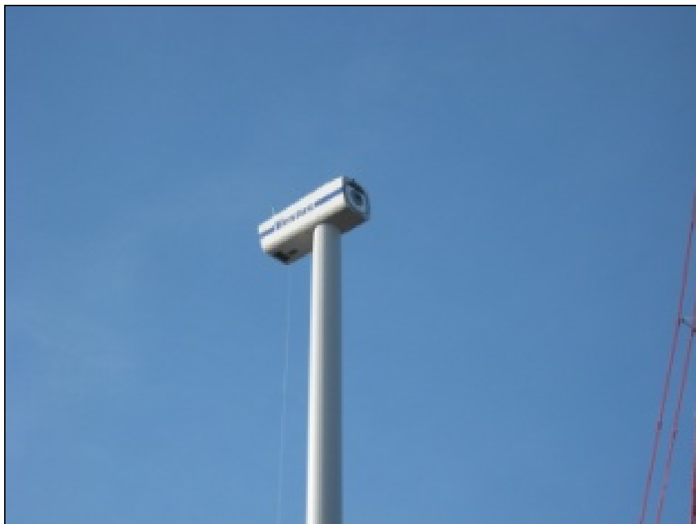
Imagen 17. Turbina eólica montada sobre la torre de un aerogenerador.
