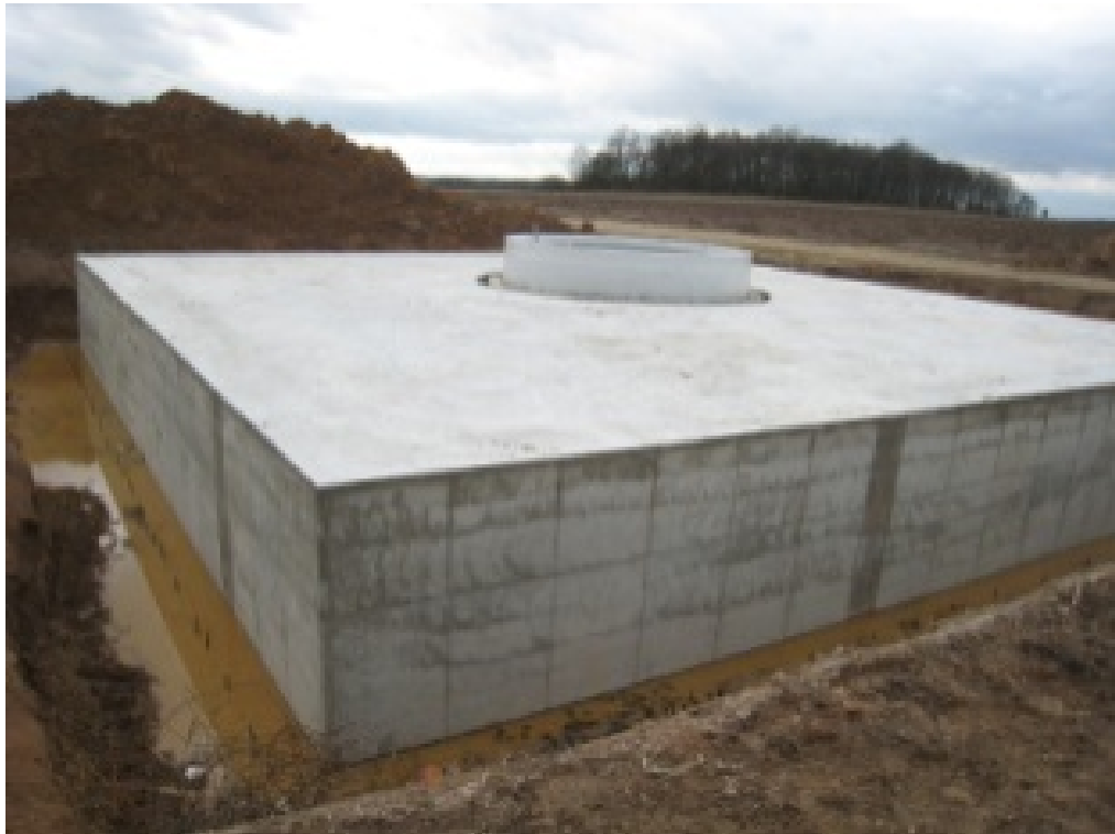
Imágenes 08. Encofrado finalizado y fraguado
