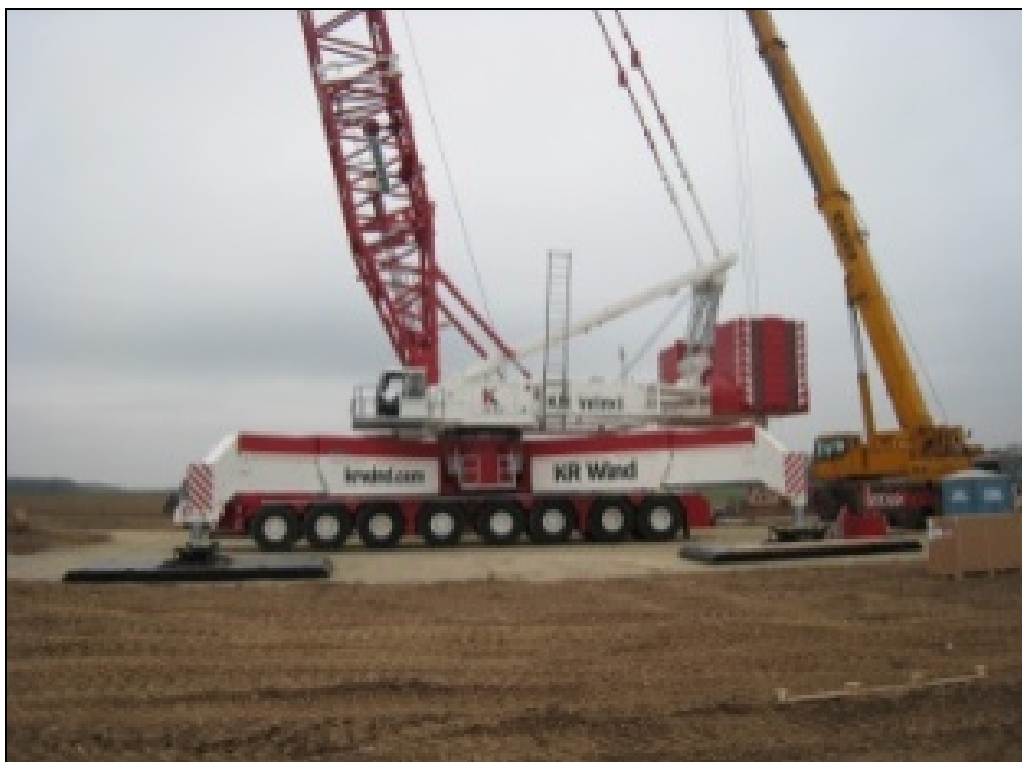
Imagen 15. Vistas de grúas (principal y auxiliar).
